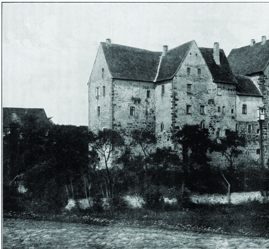
Fig. 17. Brennhäuser. Schloß. Ansicht von Südosten.
